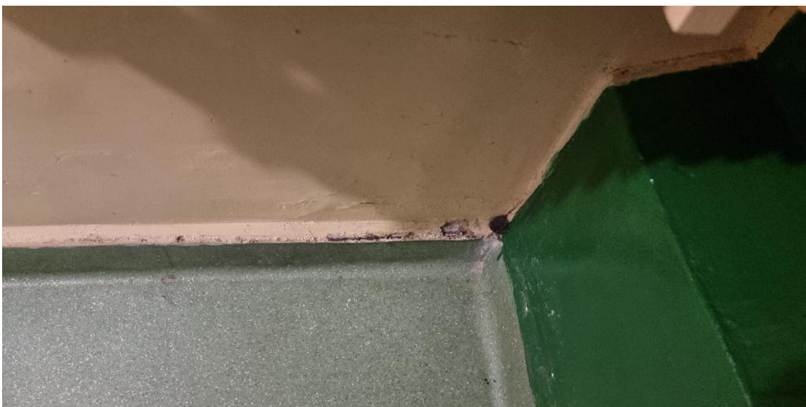
13 Widok odspojień wykładziny PCV
