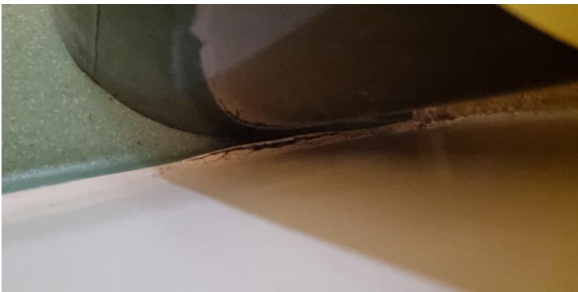
12 Widok odspojień wykładziny PCV
