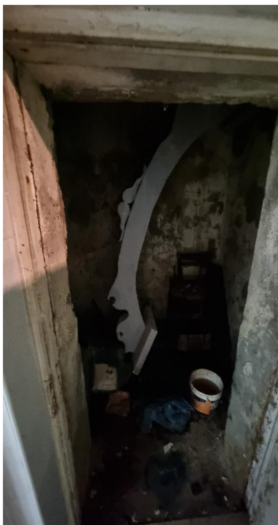
Fot. 6 Widok uszkodzeń warstwy wykończeniowej ścian wewnątrz pomieszczeń szatni
