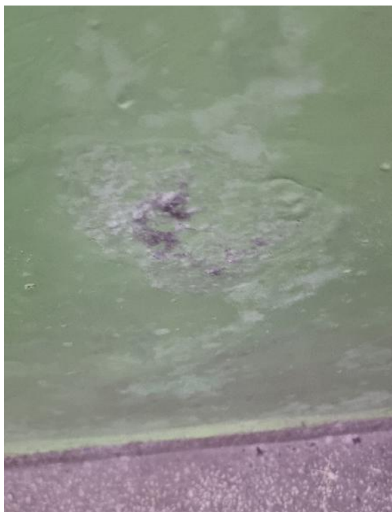
Fot. 6 Widok uszkodzeń warstwy wykończeniowej ścian wewnątrz pomieszczeń szatni
