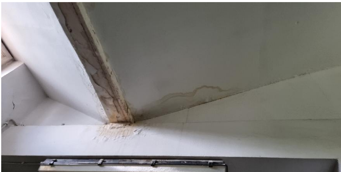
Widok zacieków nad klatką schodową – zejście do szatni
